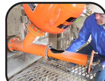
Bico de troca rápida (Y) adaptável em qualquer tipo de canhão de ar
